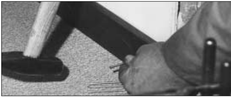
Montage von Fußleisten
