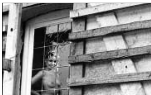
Grundlattenmontage im Mauerwerk
