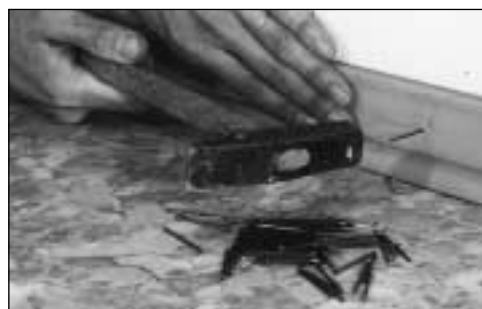
Einfache Befestigung von Fußleisten
