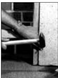
Herstellung von Verbindungen aus Holz auf Mauerwerk
