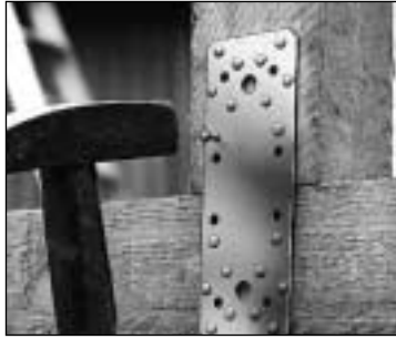
Flachverbinder zur Stielbefestigung
