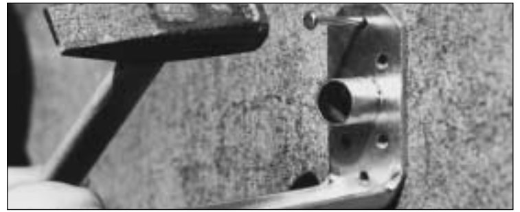
Direktmontage: Winkel auf Beton
