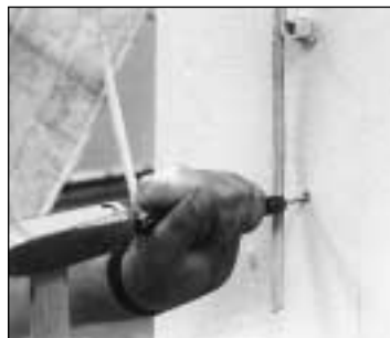
Kabelschellen-Direktmontage in Wand und Boden
