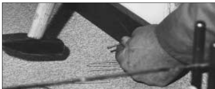
Montage von Fußleisten
