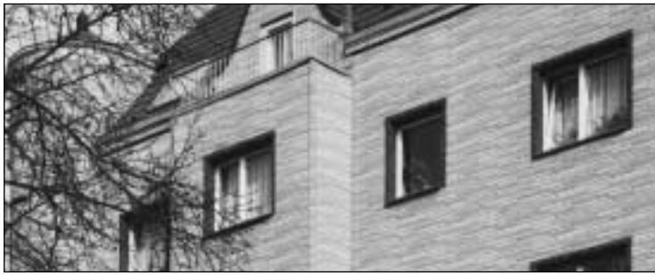
Unsichtbare Verkleidungsplattenmontage an Fassade
