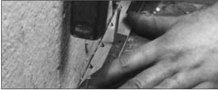
Befestigung von Abschlüßleisten auf Mauerwerk
