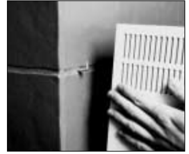
Elementmontage mit Stahlnagel in Fuge
