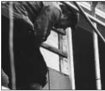
Echtschieferplattenmontage auf Fassade
