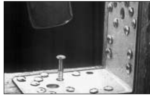
Winkelmontage: Schwelle/Stiel mit Kammnagel
