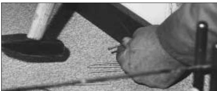
Montage von Fußleisten
