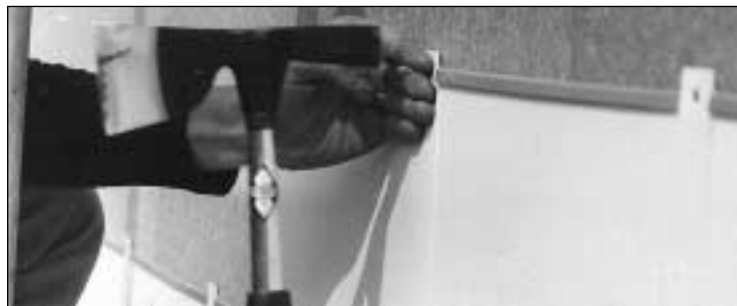
Dünnschichtmontage im Außenbereich
