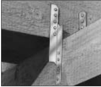
Abgehängter Balken mittels Sparrenpfettenanker
