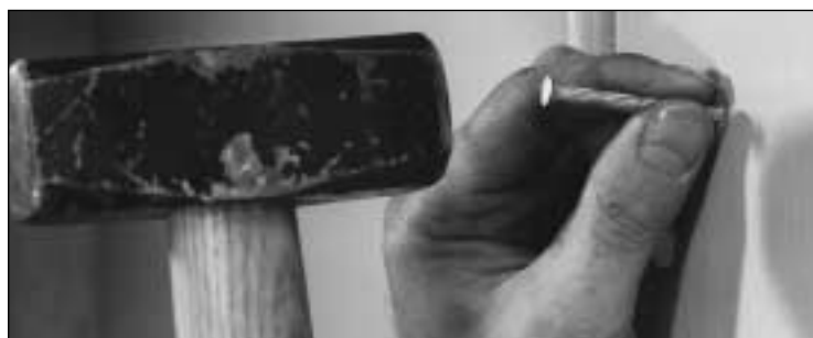
Befestigung: Holzplatte auf Beton
