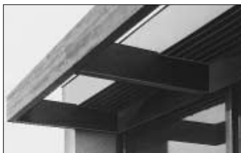
Vordachkonstruktion mit Edelstahlnagel
