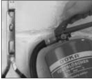
Feuerlöscher-Befestigung
