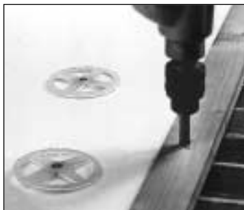
Dämmung auf Holz
