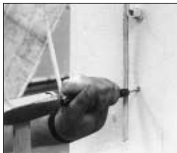
Kabelschellen-Direktmontage in Wand und Boden
