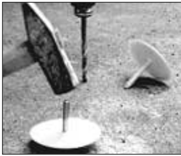
Bohren - Einschlagen
