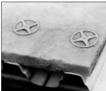
Dämmung auf Trapezblech
