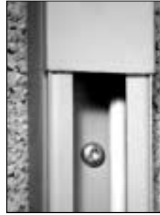
Kabelkanalbefestigung
