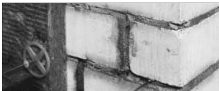
Dämmstoffbefestigung/2-schaliges Mauerwerk
