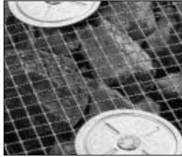
Sicherung lockerer Felshänge
