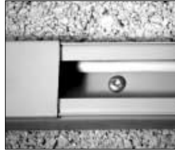
Kabelkanalbefestigung
