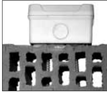
Elektromontage auf Gitterziegel
