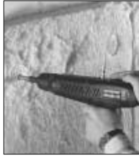
Direktbefestigung Bolzenschub
