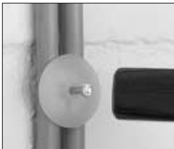
Eine Nagelscheibe für mehrere Kabel
