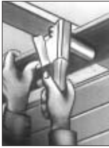
Anwendungsbeispiel der Montagezange, dadurch wird die Befestigung der Fugenkralle erleichtert
