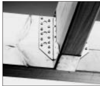
Anschluss: Haupt-Nebenträger, Holz/Holz
