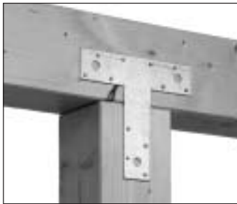
Kreuzpunktverbindung, Balken auf Pfosten, Lagesicherung
