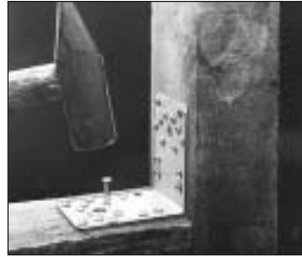
Pfosten-Riegelanschluss, Winkel auf Oberseite
