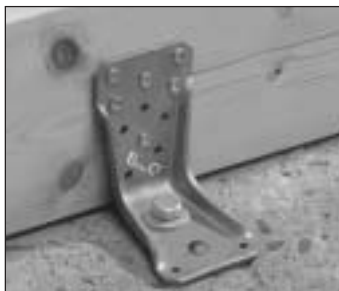
Anschluss: Balken an Beton
