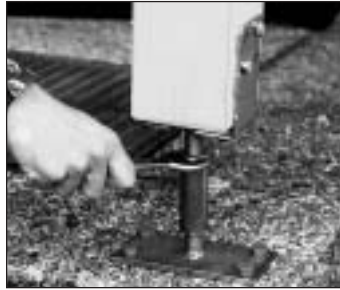
Höheneinstellung eines montierten Pfosten
