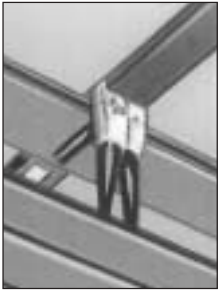
Anwendungsbeispiel der Montagezange, dadurch wird die Befestigung der Fugenkralle erleichtert
