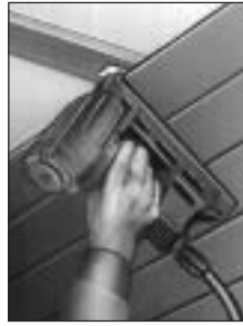
Krallenbefestigung mit Krallennägeln, Krallen-Schraubnägeln, Montagehilfen z.B. Magnet-Nagler, Kombi-Nagler, Hammer, Tacker.
