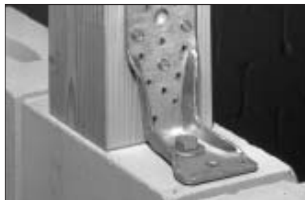
Anschluss: Schwelle an Beton/Mauerwerk
