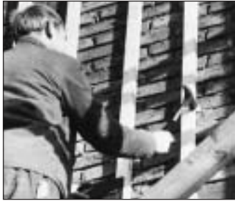
Konterlattung an Fassade
