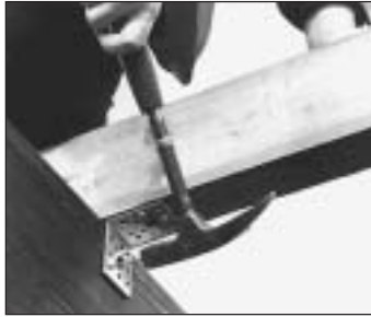
Lagesicherung mit Winkel
