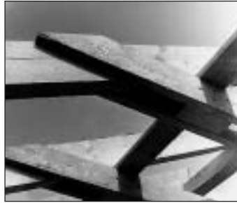
Kehlbalken am Sparren mit Sparrennägeln
