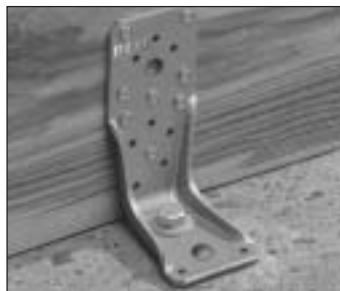
Anschluss: Träger an Beton
