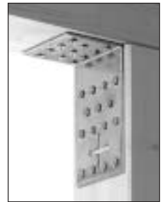
Balkenanschluss auf Pfosten
