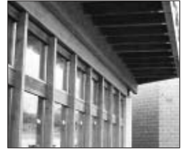
Befestigung Wand im Holzrahmenbau
