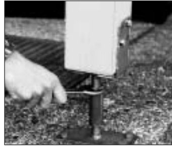
Im eingebautem Zustand kann eine Höhenverstellung vorgenommen werden.
