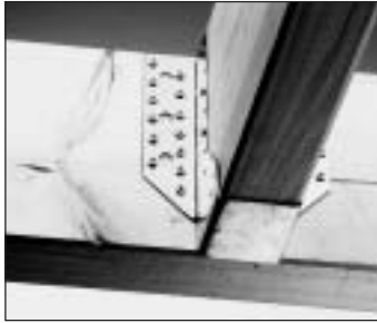
Anschluss: Haupt-Nebenträger, Holz/Holz
