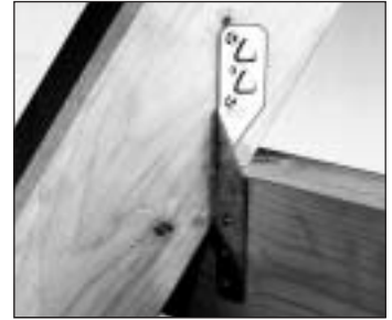
Sogsicherung Sparren an Pfette
