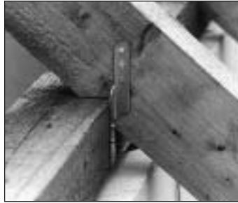
Sogsicherung Sparren
