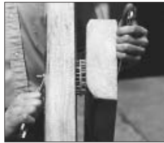
2-seitiger Einpreßdübel Typ »D«
