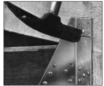
Knotenpunkt: Stütze und Balken
