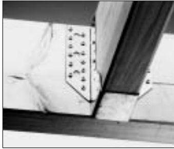
Anschluss: Haupt-Nebenträger, Holz/Holz
