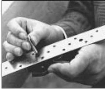
Einbau Spannclip
