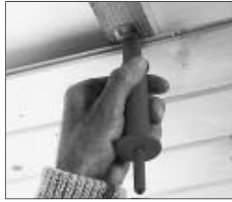
Krallenbefestigung mit Krallennägeln, Krallen-Schraubnägeln, Montagehilfen z.B. Magnet-Nagler, Kombi-Nagler, Hammer, Tacker.
