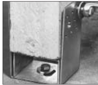
Einbaubeispiel Pfostenträger Typ »U3«, Ausrichtung kann bei fertig montierten Posten erfolgen
