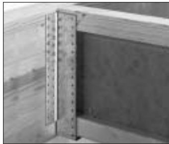
Anschluss: Hauptträger/Doppel-I-Träger
