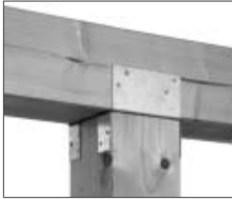
Balken-Pfostenbefestigung im Carportbau
