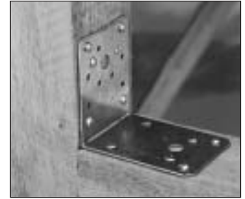
Lagesicherung mit Winkel
