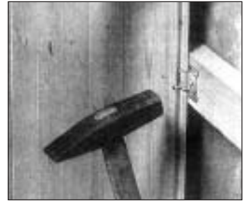
Krallenbefestigung mit Krallennägeln, Krallen-Schraubnägeln, Montagehilfen z.B. Magnet-Nagler, Kombi-Nagler, Hammer, Tacker.
