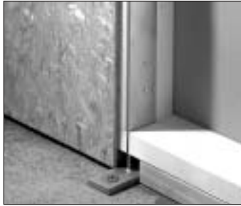
Sog-sicherung der Wände im Holzrahmenbau
