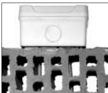
Elektromontage auf Gitterziegel
