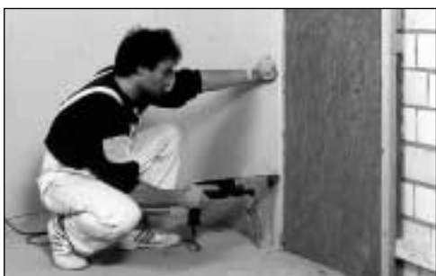
Schneller Innenausbau durch gegurtete Schrauben
