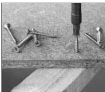
Verlegeplattenmontage auf Traghölzern
