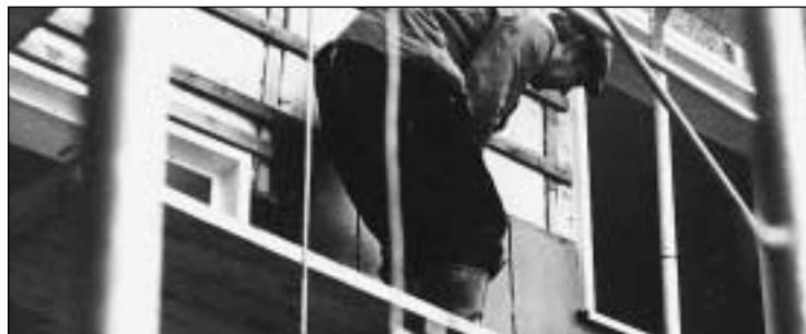
Anbringung von Grundlattung und Fassadenplatten mit A2-Euro-Bohrschrauben*
