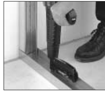
Befestigung von Trockenbauprofilen
