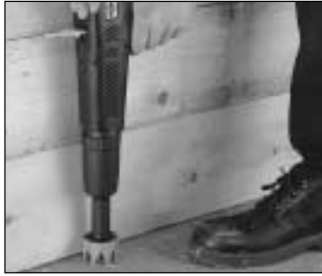
Setzen von Schalungsanschlagen
