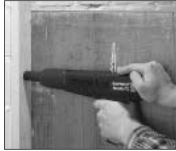
Montage von Holzplatten
