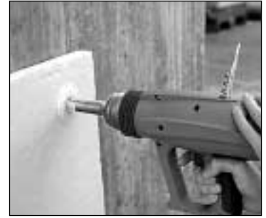
Montage von Polystyrol-Platten
