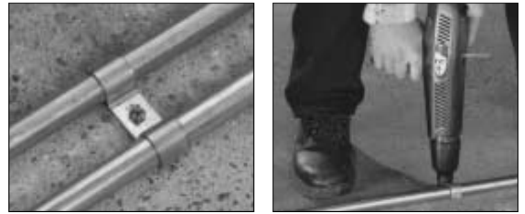
Rohrbefestigung mit Fixbriden
