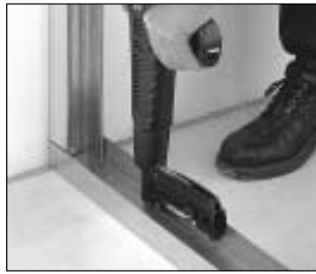
Befestigung von Trockenbauprofilen
