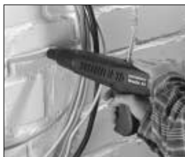
Setzen von Kabelbügeln
