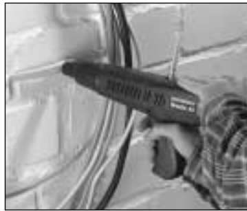
Setzen von Kabelbügeln
