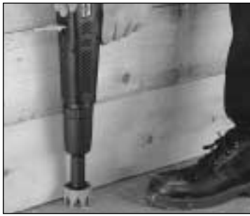
Setzen von Schalungsanschlagen
