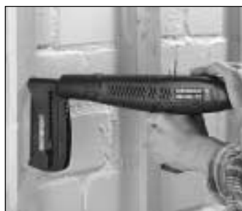
Befestigung von Grundlattung
