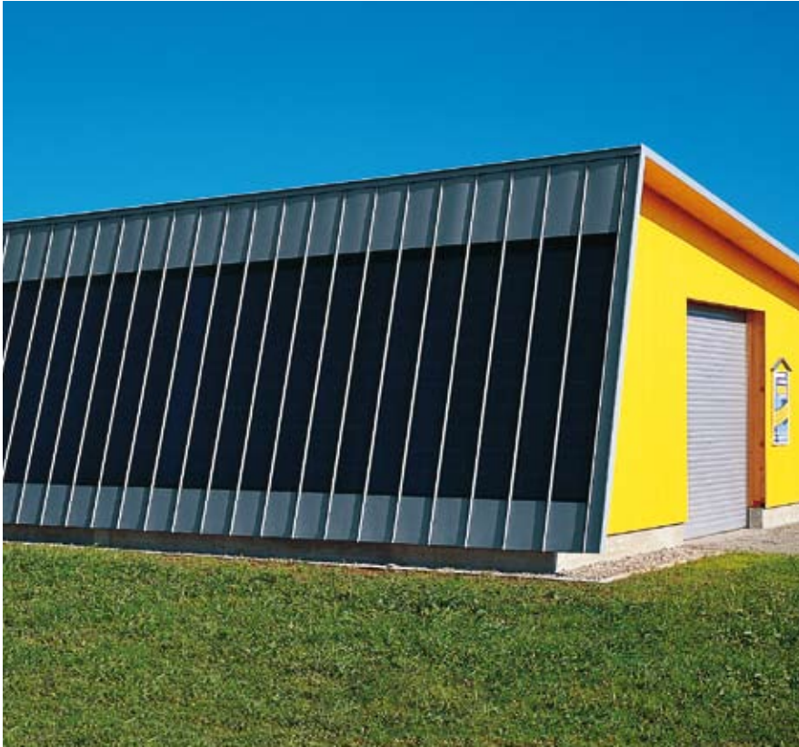
Lehmann Küchen GmbH warehouse, Rust, Germany
