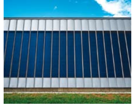
Lehmann Küchen GmbH warehouse, Rust, Germany
